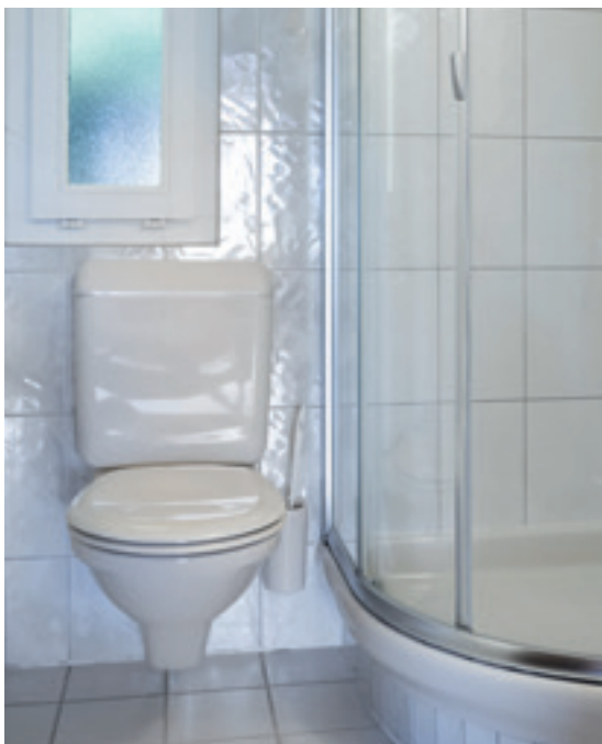
VORHER Einbausituation mit Aufputzspülkasten
